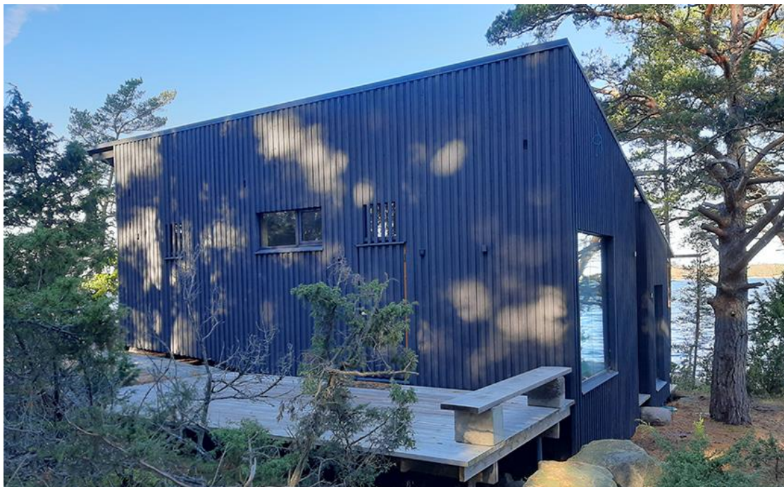
Kuva 7. Eräs alueen talousrakennuksista.
