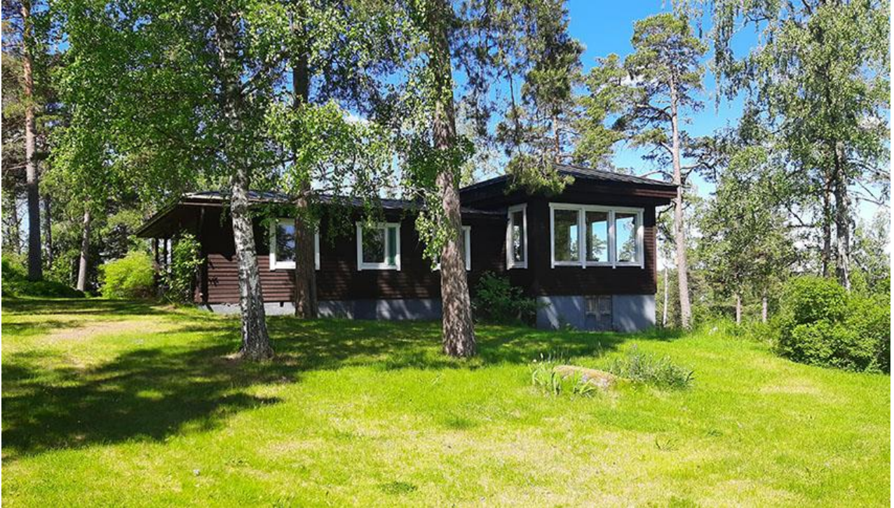
Kuva 1. Alueen itäosan olemassa oleva asuinrakennus. Kuva otettu länteen.
