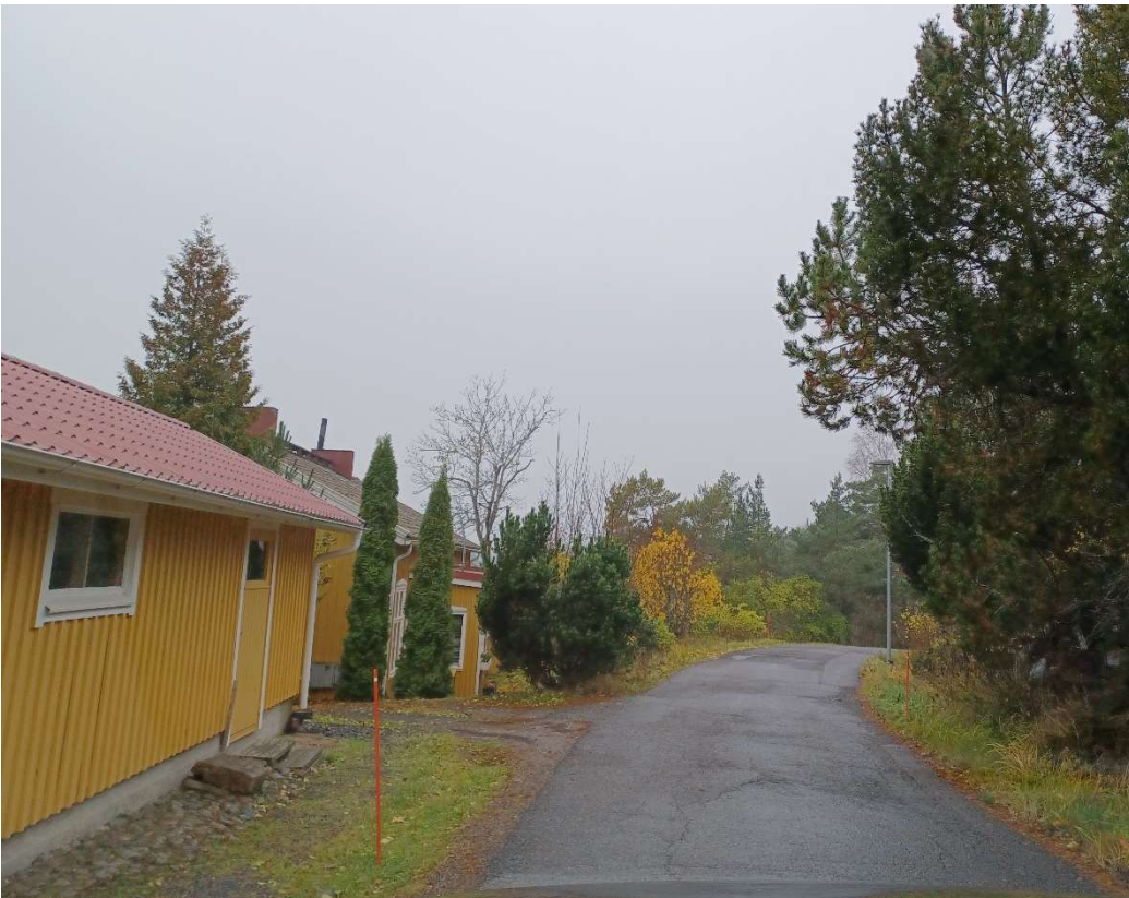
Kuva 3. Dragsedentie on kapea ja rakennukset ovat paikoin hyvin lähellä tietä.
