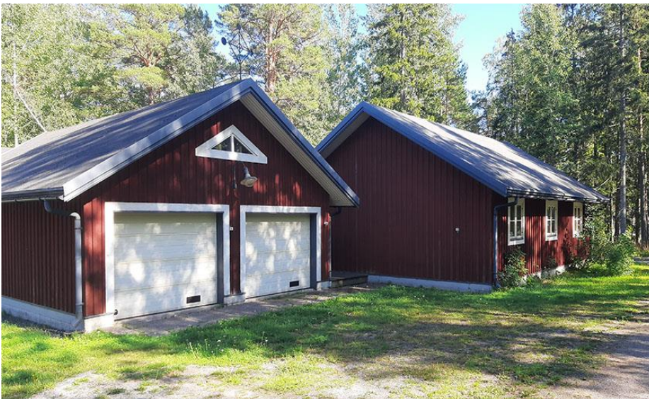
Kuva 6. Autotallit ja varastorakennus.
