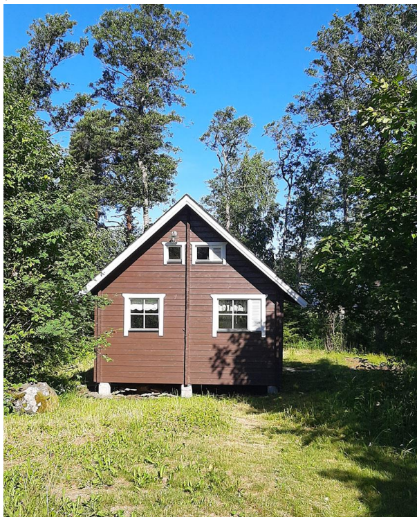
Kuva 5. Vierasmaja, pätyseinä maihin päin.
